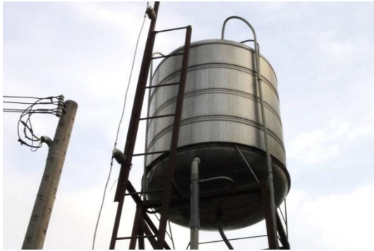
圖 1 無遮蓋的豎高式不鏽鋼水塔，在炎熱的夏季提供母豬可能是熱的飲水。
